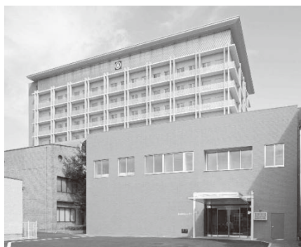
本館・救命救急センター
