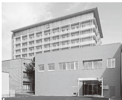
本館・救命救急センター
