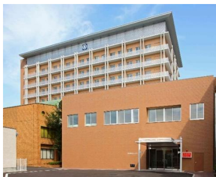
本館・救命救急センター
